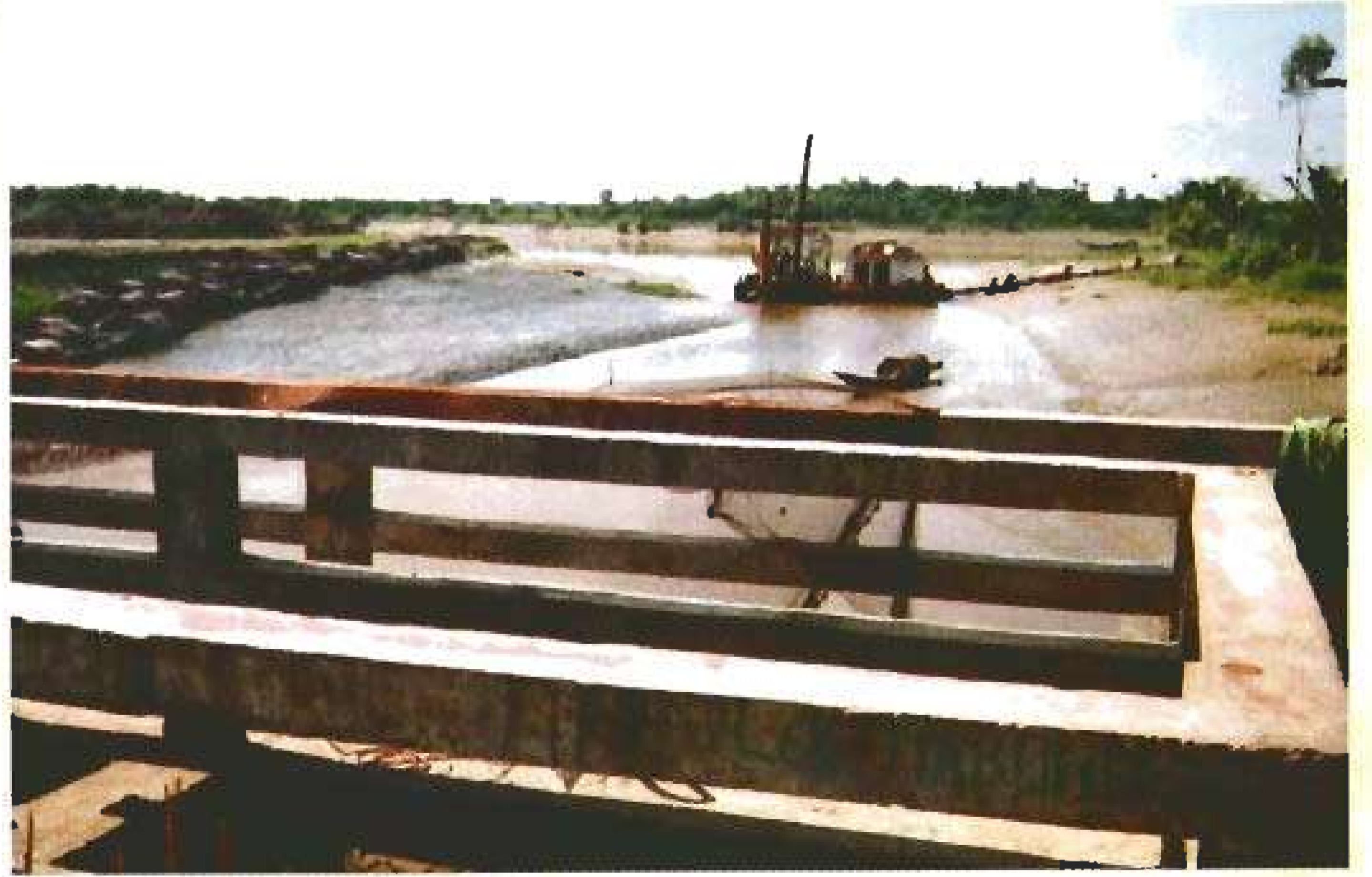
বিল ডাকাতিয়া অঞ্চলের পানি নিষ্কাশনের জন্য কেজেডিআরপি প্রকল্পে নির্মিত শৈলমারী রেগুলেটরের সামনে সার্বক্ষণিকভাবে ড্রেজিং করার পরও ক্রমান্বয়ে ভরাট হয়ে যাচ্ছে নিষ্কাশন খাল
